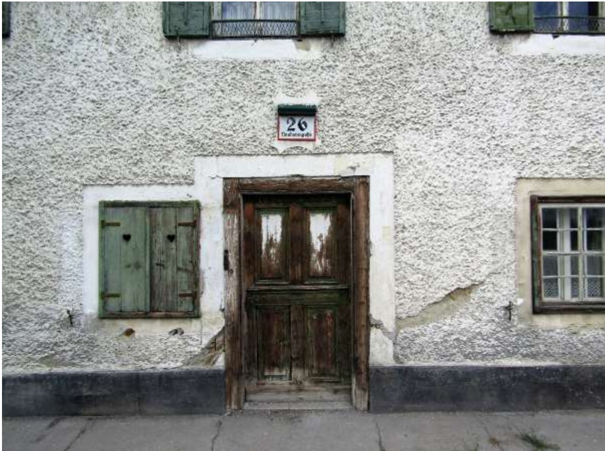
Abb. 35: Der Eingang zum ehemaligen Scharfrichterhaus
